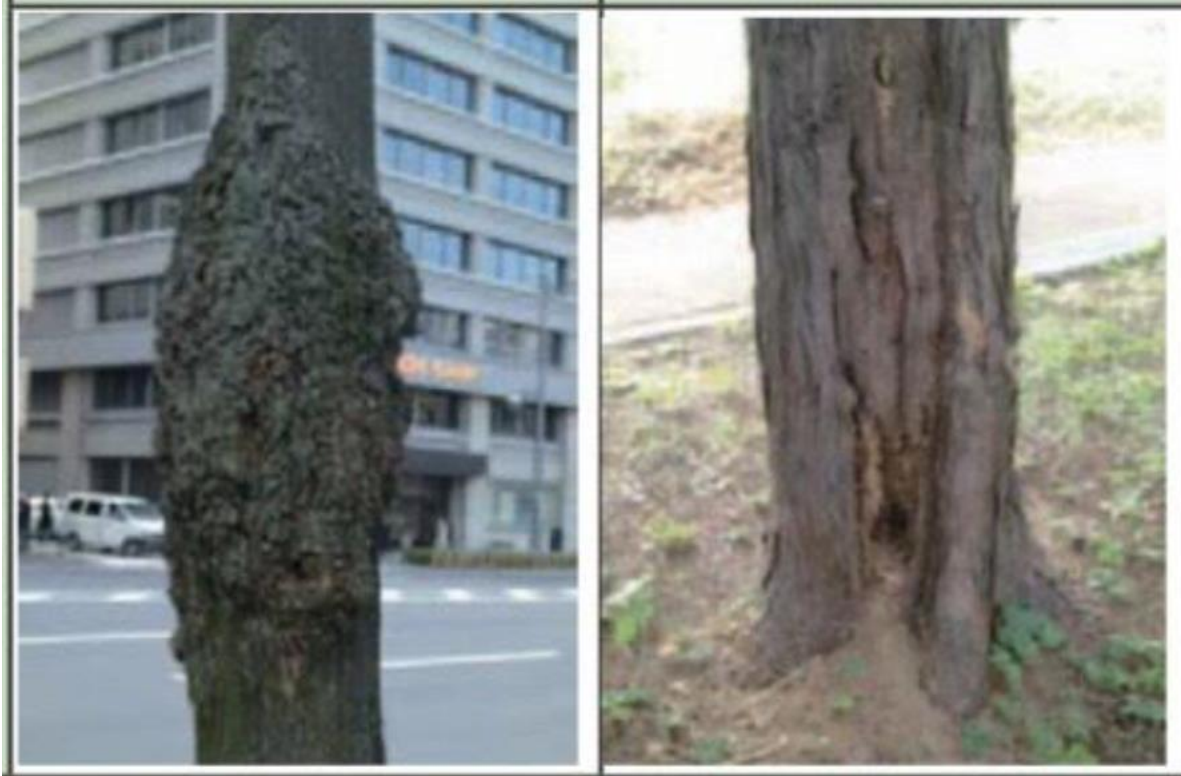
Kondisi batang yang rapuh
