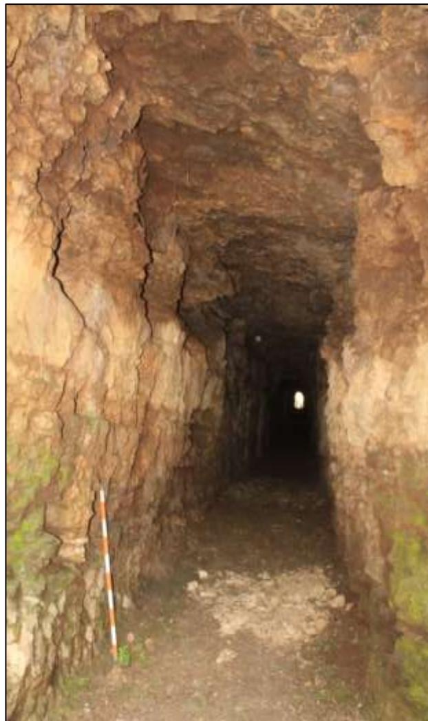
Gambar 5. Kenampakan trowongan bagian selatan
