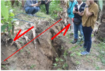
Surface rupture Gempa 2018 di uji paritan paleoseismologi: 320cmS/70cmD
