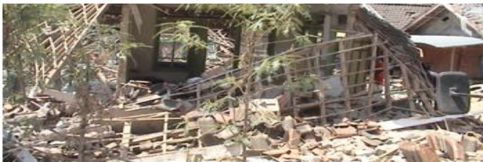
Gbr 7. Kerusakan Rumah di Dukuh Boto Kodung, Dusun Cerpap, Desa Kedunglo
