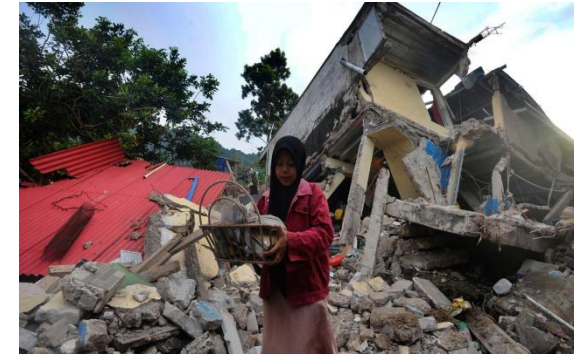
Struktur kolom & balok lemah
