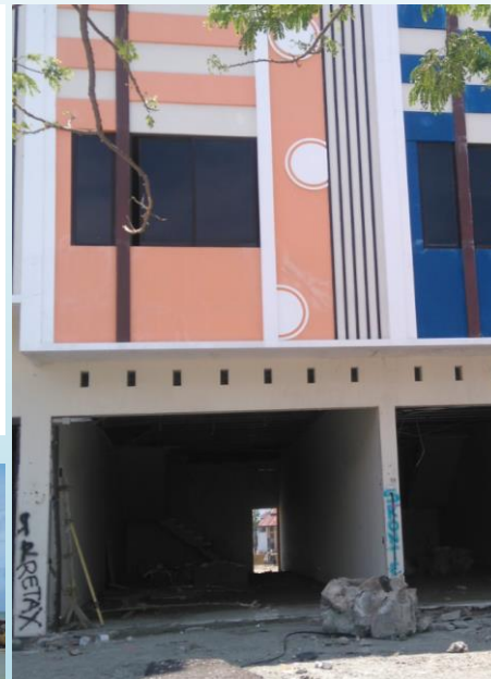
Bongkahan seawall yang terbawa gelombang Tsunami di Palu
