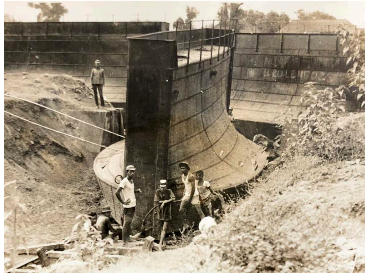
Penggalan caisson dari Bendung Lengkong lama (1857)
