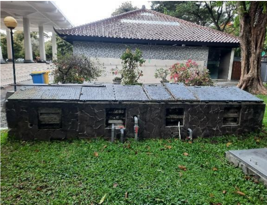
IPAL untuk mengolah limbah air wudhu di Masjid Manarul Ilmi ITS
