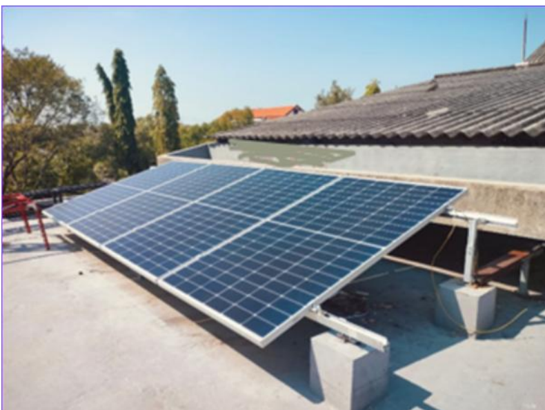
Pemasangan Panel Surya di beberapa gedung ITS
