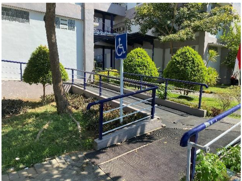
Fasilitas untuk disabilitas
