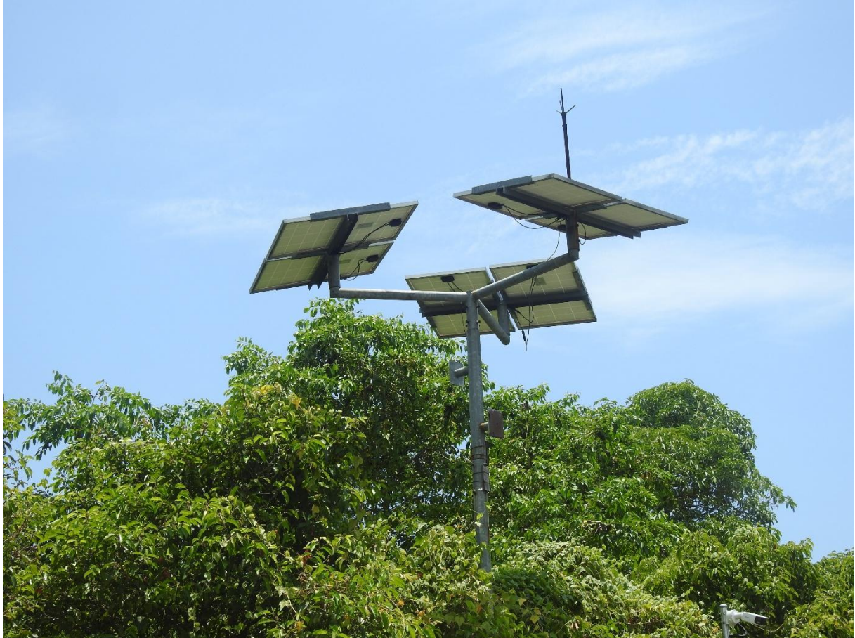
Panel surya yang dimanfaatkan untuk PJU dan CCTV
