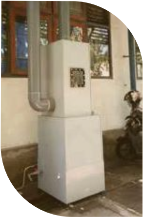
Pipa Pembuangan khusus udara asam dari laboratorium
