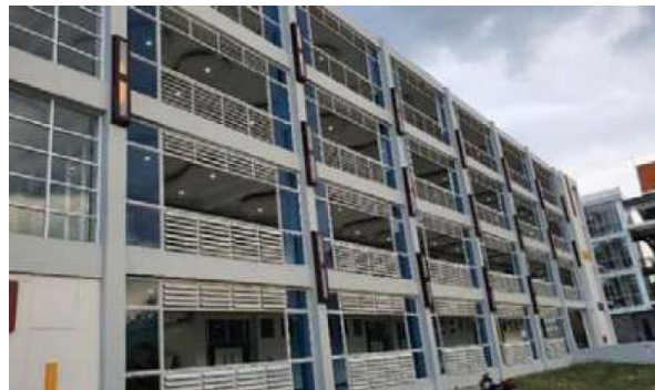
Pemasangan overhang pada Gedung Departemen Desain Interior
