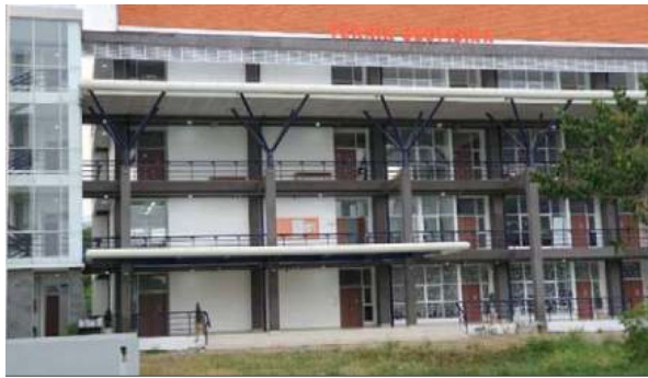
Pemasangan overhang pada Gedung Departemen Teknik Geofisika
