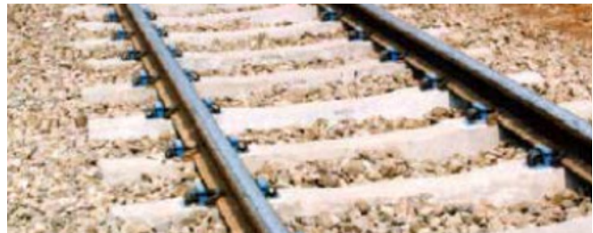
Gambar 5.4 KA-Clip di Cimahi-Bandung (1997) R 42 rail type
