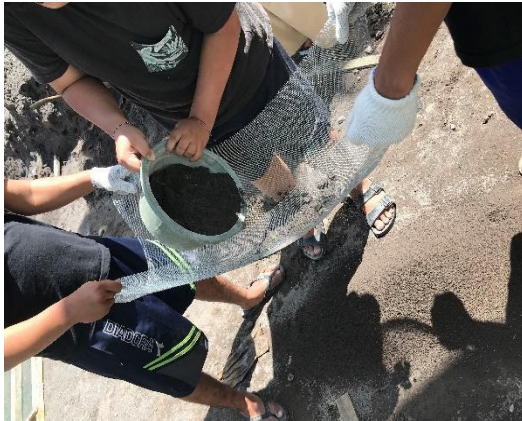
Gambar 2. Proses pengayakan pasir
