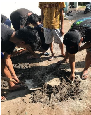
Gambar 3. Pembuatan adonan pasir dan semen
