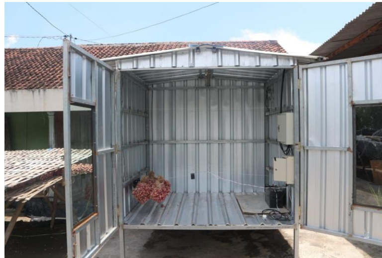
Tampilan bangunan instore drying dengan panel surya cerdas yang dilengkapi dengan sensor suhu dan bantuan mikrokontroler rancangan tim KKN Abmas ITS untuk membantu petani bawang
