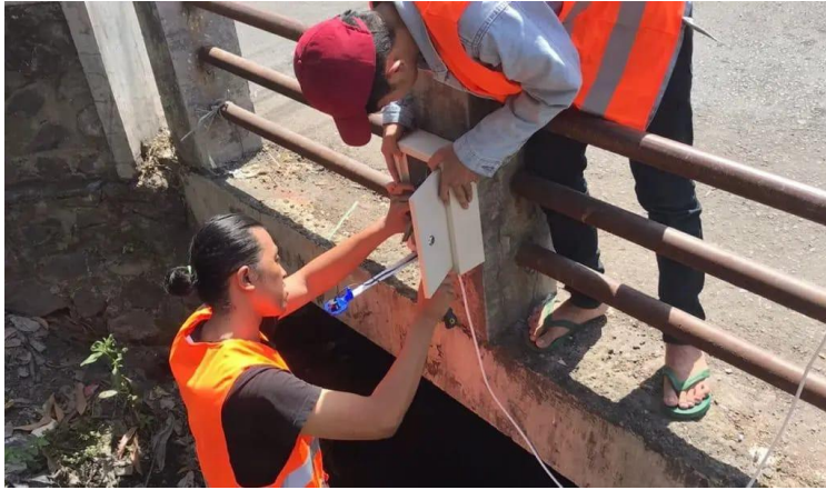
Salah satu kegiatan KKN-PM pemasangan alat penakar hujan otomatis yang dilakukan oleh mahasiswa ITS
